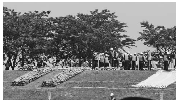
消防団による立蛇籠工・T型マット工設置作業
